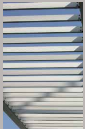
pergolato realizzato con profilati scatolari
